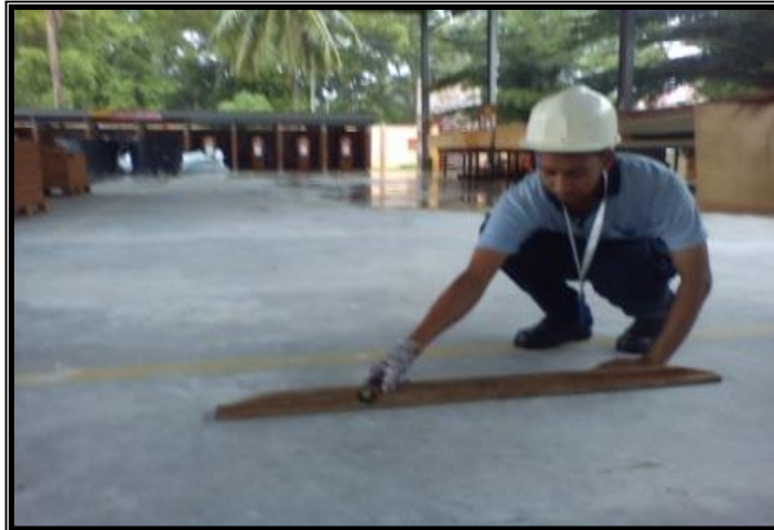
Rajah 2 : kerja memaras dan meratakan lantai
