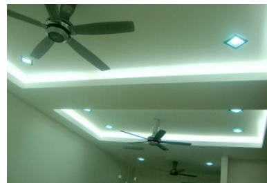
Sistem Pengcahayaan dan Pengudaraan di dalam bangunan
